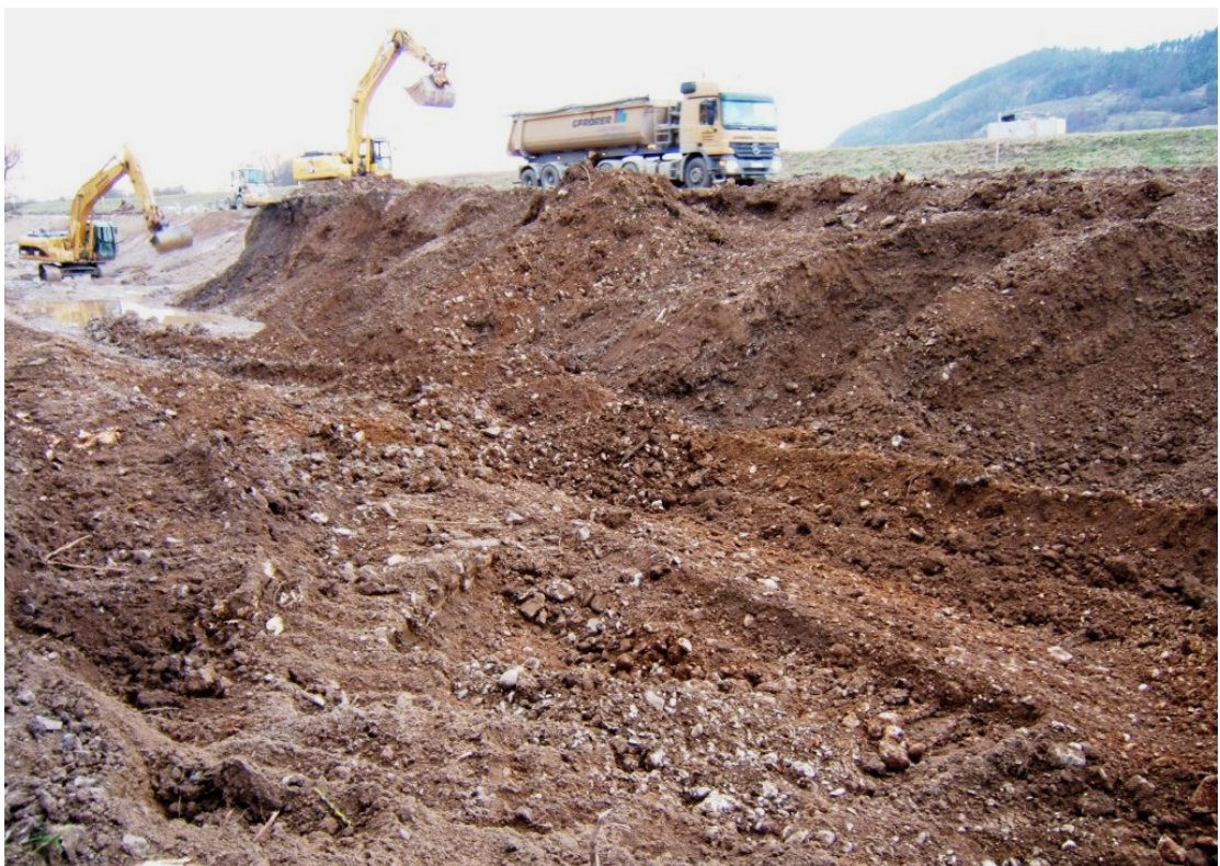
Abb. 5: Der Oberboden und die kiesige Zwischenschicht bis zum Grundwasserniveau werden zuerst abgebaggert, da sich dieses Material aufgrund des hohen Anteils von Ton, Sand und Boden für die Aufschüttung im See nicht besonders gut eignet.
