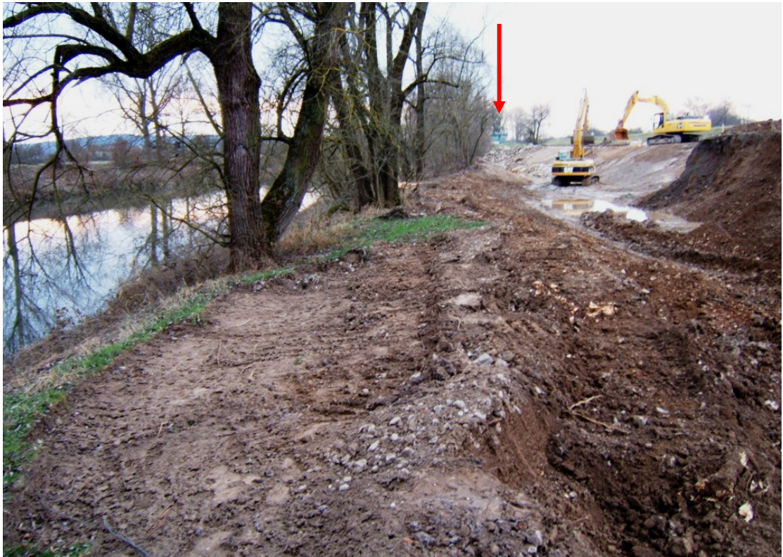
Abb. 4: Entnahmestelle für das Schüttmaterial. Aus diesem Bereich, ca. 70m unterhalb der Wehranlage (s. Pfeil) und ca. 20m vom Neckar entfernt, wird das kiesige Material für die Aufschüttung entnommen.
